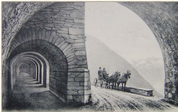
Fig. 16: Passtrasse über den Simplonpass mit Sommerstrasse und Lawinengalerie für den Winter.
